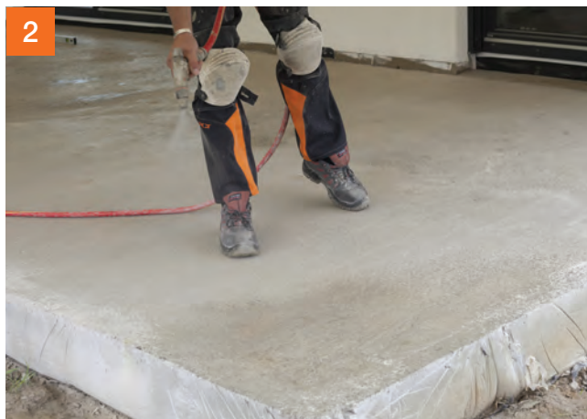
Podklad vopred navlhčiť. Zamedziť tvorbe kaluží.
