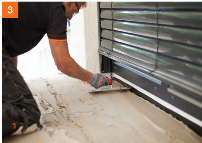
Podklad vyrovať, prípadne vytvoriť dostatočný sklon 1,5 – 2,0 % s PCI Pericret®.
