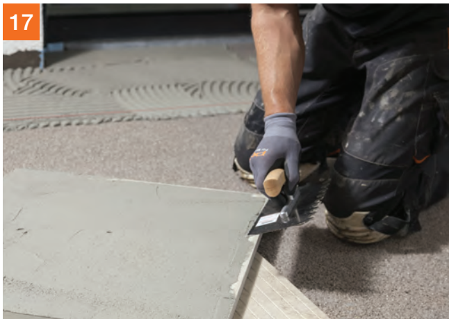
Zhotovenie záškrabu na dlažbu.
