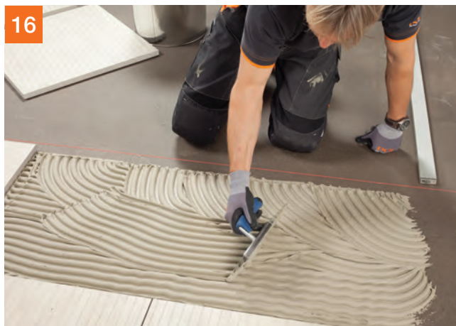
Nanesenie PCI Flexmörtel® S2 hladidlom s dostatočnou veľkosťou ozubenia v závislosti od podkladu.
