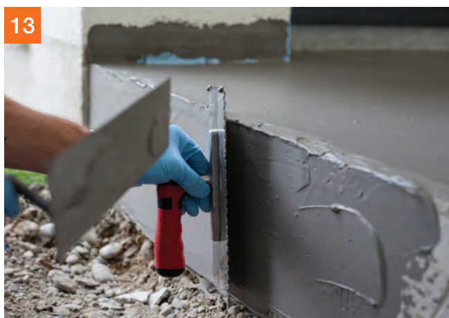
13 Zaizolovať čelnú stranu s PCI Seccoral® 2K Rapid (na balkónoch až po odkvapovú hranu).
