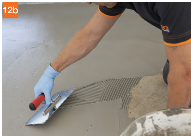
12b Nanesenú vrstvu vyrovať hladidlom.
