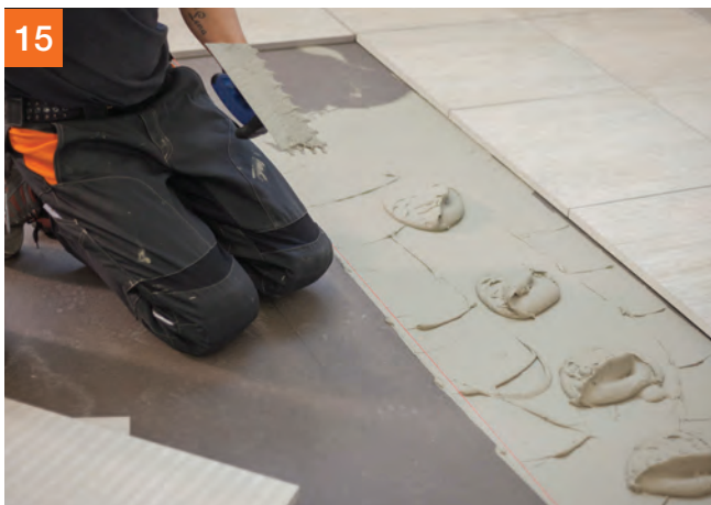
Zhotovenie záškrabu na podklad s PCI Flexmörtel® S2.
