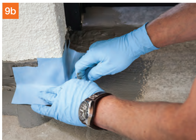
9b Umiestniť rohové tesnenie PCI Pecitape® 90° I/A do PCI Seccoral® 2K Rapid.
