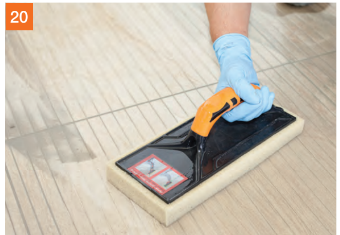
20 Čistenie prebytočnej škárovacej hmoty.
