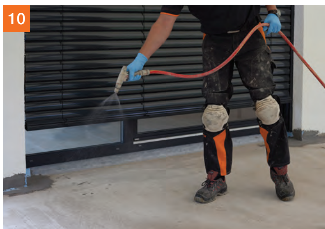
10 Podklad vopred navlhčiť tak, aby bol matný. Nesmú vzniknúť kaluže.
