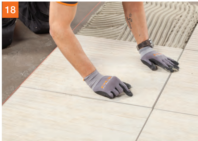
Dlažbu usadiť na požadované miesto rovnomerným silným tlakom a dorovnať opakovanými posunmi.
