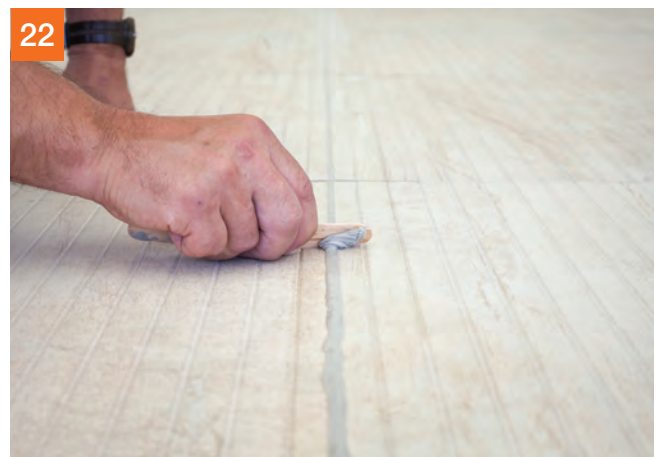
22 Vyhladenie čerstvo nanesej škárovacej hmoty v dilatáciách.
