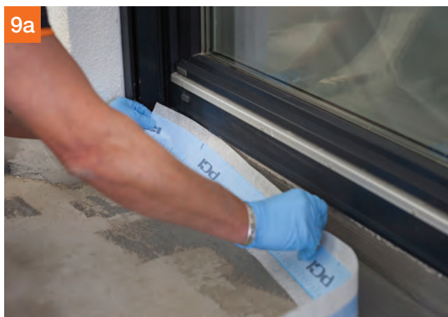
9a Tesniacu pásku PCI Pecitape® 120 nalepiť do PCI Seccoral® 2K Rapid.
