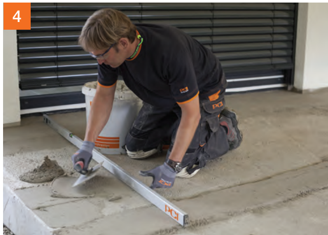
Pri zhotovovaní spádovej vrstvy najskôr vytvoriť dva vodiace pásy tak, aby vodiaca lata bola v požadovanom sklone. Potom strhnúť povrch latou do roviny.
