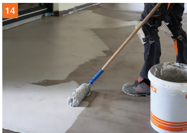
14 Po cca 4 hodinách naniesť druhú vrstvu. Hrúbka suchého súvrstvia hydroizolácie musí byť minimálne 2 mm.
