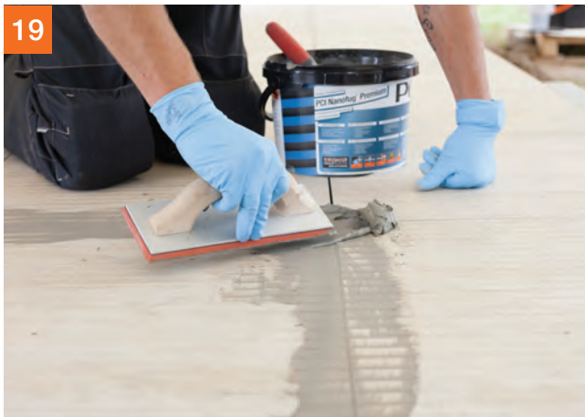
19 Vyškárovanie dlažby s PCI Nanofug® Premium.
