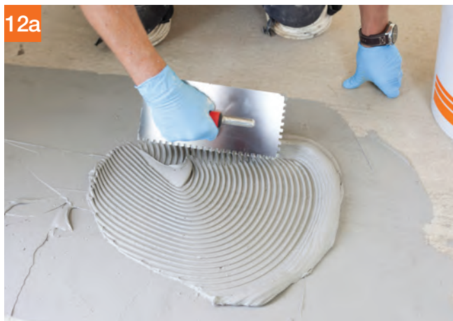
12a Na kontaktnú vrstvu naniesť PCI Seccoral® 2K Rapid hladidlom s ozubením 6 mm.
